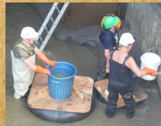
Récupération du poisson pour transport hors zone de travaux à l'aide d'une cuve oxygénée.
